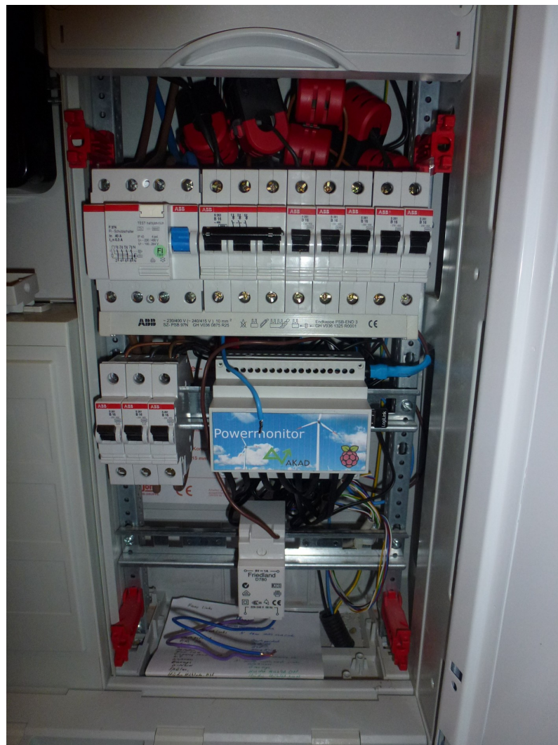
Abbildung 25: Der Energiemonitor im Verteilerschrank
